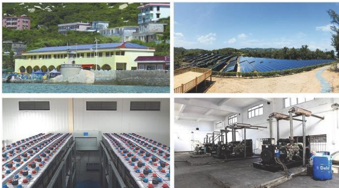
Fig. 2. Main elements of hybrid micro-grid (a) BAPV; (b) PV power plants; (c) BESS; (d) DGs.
